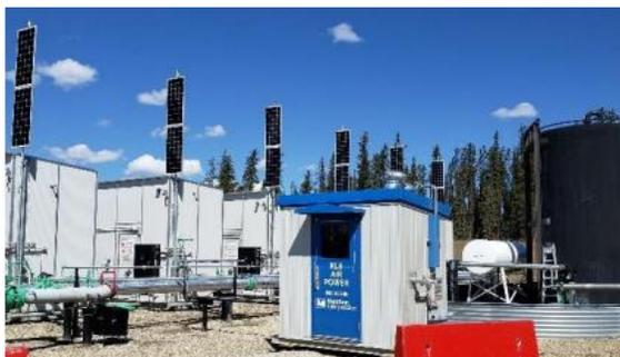
En un caso específico, Shell Canada actualizó el diseño de su plataforma de pozos en su negocio de esquisto en Alberta en 2019, para eliminar las emisiones de metano de los dispositivos neumáticos mediante la transición al aire de instrumentos. En ese momento, Shell utilizó generadores excedentes con un banco de carga para suministrar la energía necesaria para hacer funcionar un compresor de aire en sus sitios.
