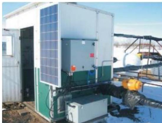
separador modernizado con sistema de control eléctrico solar Bear
